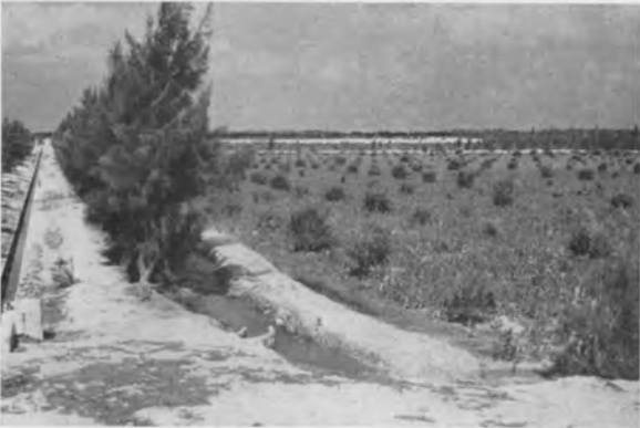
Bild 5: Im Wadi el-Natrûn wird oberflächennahes Grundwasser in Kanälen gesammelt und von dort in die Bewässerungsgräben gepumpt.
