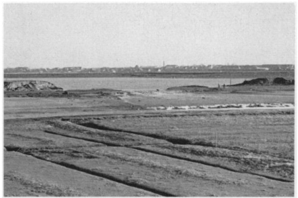
Bild 1: Blick vom Deich des Finkhaushalligkooges auf den Deichbruch im Dockkoog bei der Husumer Schleuse. Man erkennt, wie das Wasser aus dem vollgelaufenen Koog am Morgen nach der Sturmflut abläuft. Im Hintergrund die Häuser von Husum. Das Bild verdanke ich der Freundlichkeit von Herrn Pressephotograph Hoffmann aus Husum. Aufn.: 17. 2. 62, Hoffmann (Husum)
