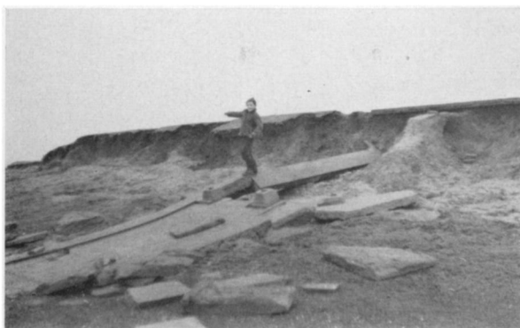
Bild 3: An der Spitze des Dockkooges ist ein Kliff am Deich ausgebildet worden, das besonders links im Bild gut ausgeprägt ist. Es hat eine Höhe von etwa 1 1/2 m. Im Vordergrund die Reste einer Brücke, die auf den Deich führte. 4. 62
