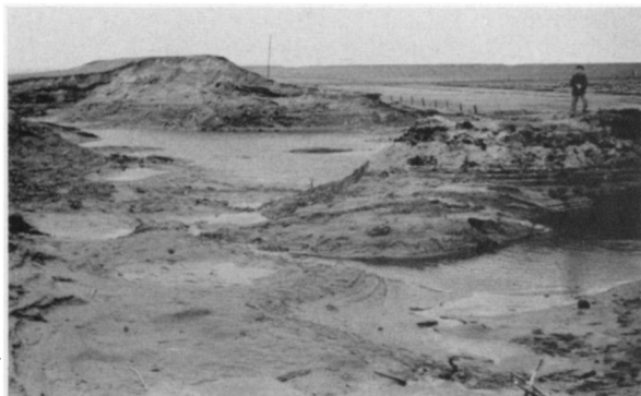
Bild 2: Der Deichbruch im Dockkoog (vgl. Phot. 1) aus der Nähe. Der in der Mitte stehengebliebene Teil läßt die Vermutung zu, daß dieser Deichbruch aus zwei isoliert vorgehenden Kolken entstanden ist. 4. 62
