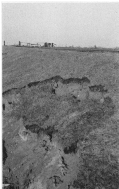
Bild 7: Zu erkennen ist die Weiterentwicklung eines Kolkes. Mit Soden bedeckte Stücke reißen aus und stürzen in den Kolk. Hier ein Beispiel vom Westteil des Ülvesbüller Deiches. 10. 4. 62
