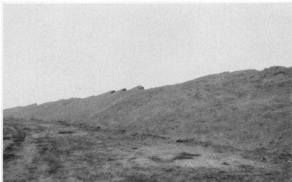
Bild 6: Der Deich des Norderheverkooges von der Binnen-seite aus gesehen. Man erkennt, wie weit das Kliff schon über die Deichkrone hinweggegangen ist. 11. 4. 62
