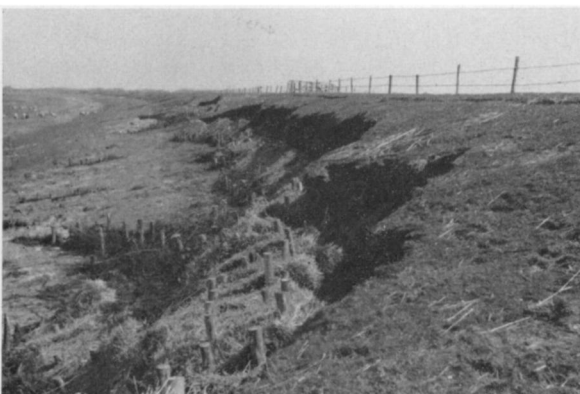
Bild 4: Die Entwicklung eines Kliffs am Deich läßt sich aus dieser Aufnahme vom Christianskoog (nördlich von Meldorf) gut erkennen. Die im Vordergrund noch isoliert vorgetriebenen Kolke sind in der Mitte des Bildes schon zusammengewachsen. Stroh und Reisig (Faschinen) werden durch eingerammte Pfähle befestigt und dienen zum vorläufigen Schutz der angegriffenen Deiche. 17. 4. 62
