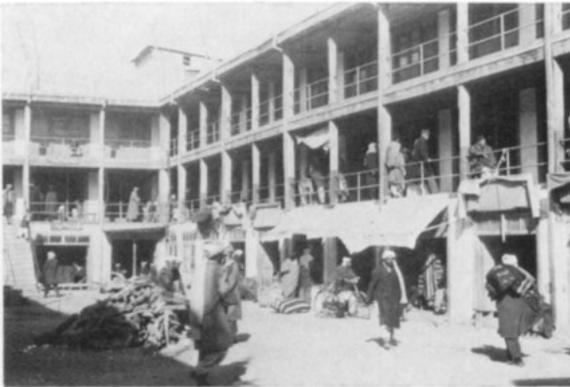
*Photo 5:* Serai-Neubau, Ende der fünfziger Jahre in Bāgh-e Umūmī, noch stark dem traditionellen Stil verhaftete Holz-Ziegel-Konstruktion mit Läden und Handwerker-räumen im Erdgeschoß, Großhandelslägern und Büros in den Obergeschossen (Aufn. Verf. 1968)
