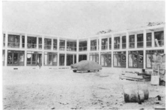
*Photo 6:* Serai-Neubau 1968 in Bāgh-e Umūmī in Stahl-Beton-Konstruktion mit abgeschlossenen Läden im Erdgeschoß und Läden und Büroräumen im Obergeschoß (Aufn. Verf. 1968)
