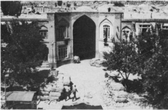
Photo 3: Bazar von Tabriz. Innenhof und Eingangstor eines Karawansarai-Hofes. Die Räume in beiden Geschossen beherbergen vor allem Großhandelskontore, der Hof selbst dient als Lagerraum
