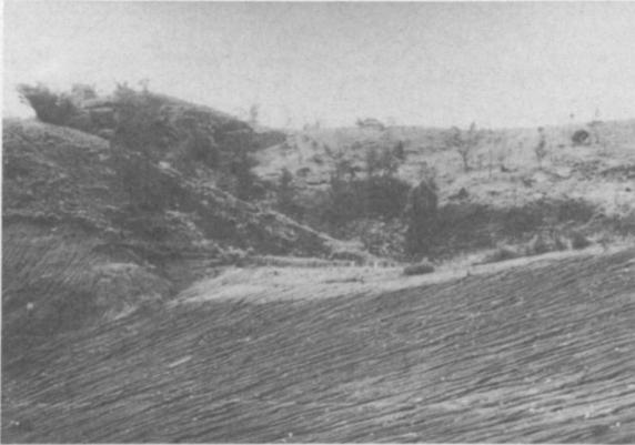
*Photo 5:* Straßenaufschluß bei Kundiawa. Durch Abräumung der Humusschicht (Oberboden) an einer Straßenböschung kommt es zu spontanen kräftigen Bodenerosionserscheinungen, während die dahinterliegenden steiler geböschten Areale im Schutze einer 30 cm mächtigen Humusdecke sich durch eine ausgeprägte Hang- und Bodenstabilität auszeichnen
