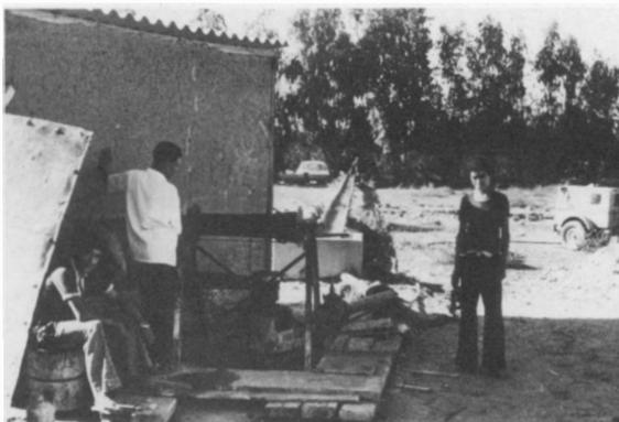
Photo 2: Brunnenarbeiter bei der Grabungstätigkeit zur Vertiefung eines Brunnenschachtes von derzeit etwa 60 m Tiefe. Rechts im Hintergrund ist der Kompressor zu erkennen, mit dem ein Preßluftbohrer betrieben wird (Aufnahme 21. 10. 1978)
