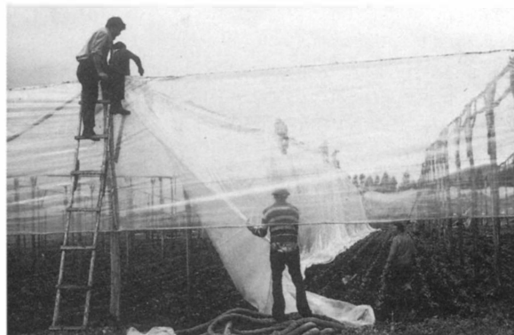
Photo 3: Aufbau von Folien-Dächern. Aufnahme: E. GORMSEN Construction of greenhouses
