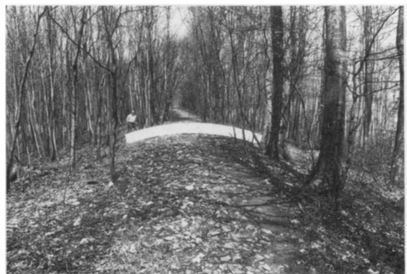
Photo 2: Grenzbeispiel von zugeschärftem und abgerundetem Scheitel: Querwölbungsradius 10 m (vgl. Schablone)
