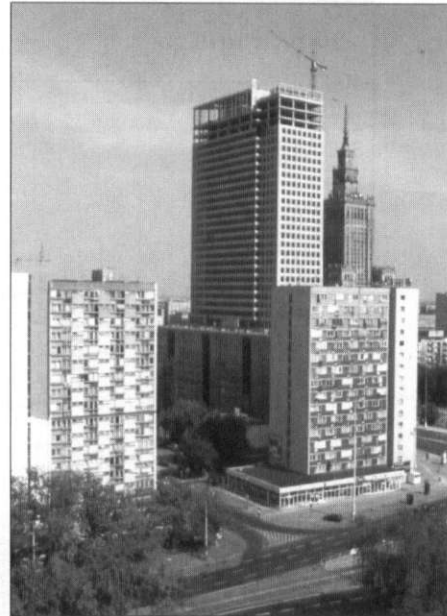
Photo 1: Neubau des Warsaw Financial Center in innerstädtischem Wohngebiet
