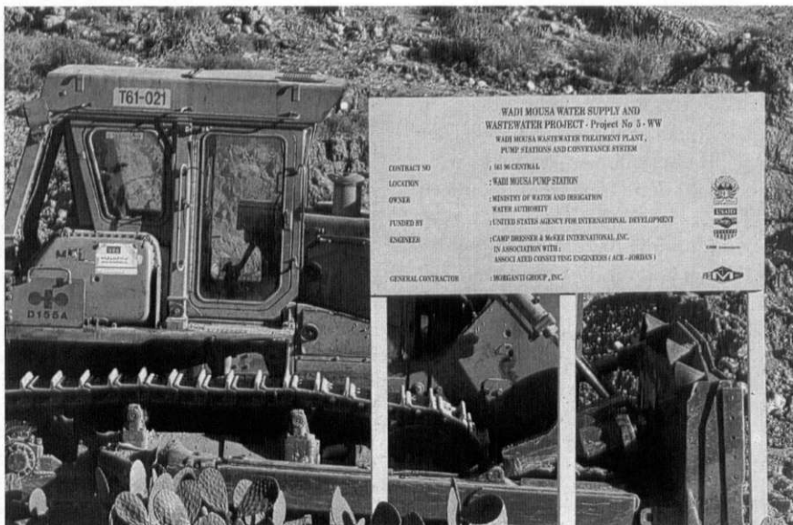
Photo 7: Neubau einer Kläranlage für Wadi Musa Construction of sewerage works in Wadi Musa
