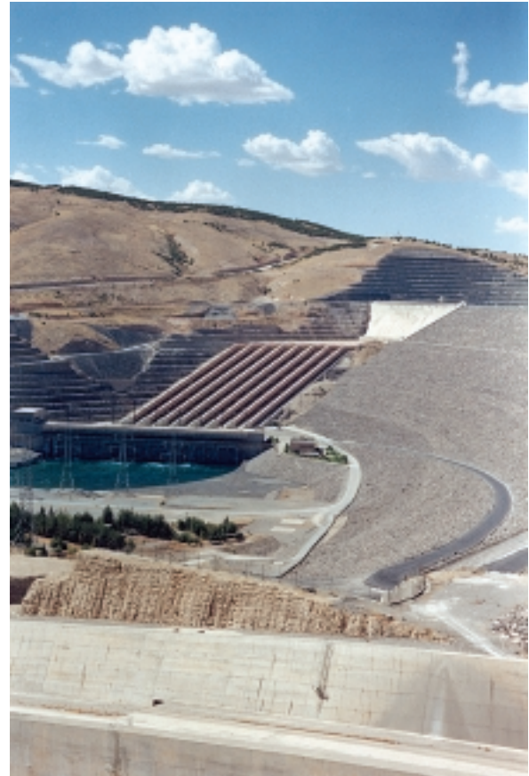
Photo 1: Atatürk Dam Photo: K. ÖKTEM Atatürk Damm
