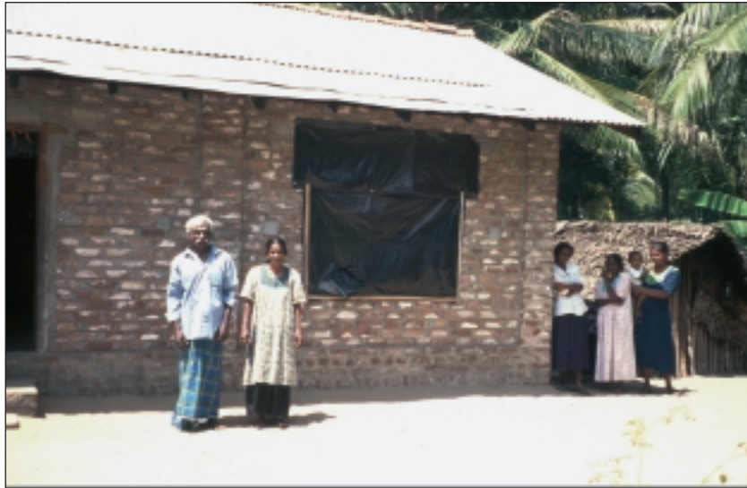
Photo 2: Reconstruction of destroyed houses by neighbourhoods Wiederaufbau zerstörter Häuser in Nachbarschaftshilfe
