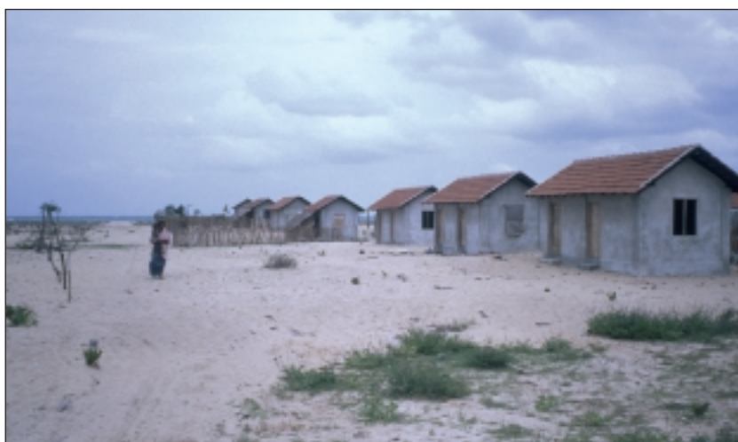
Photo 3: Fishermen’s housing scheme at Palameenmadu Sozialer Wohnungsbau für Fischer in Palameenmadu
