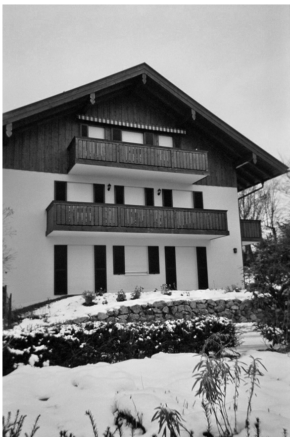
Photo 4: Temporary vacant house in Tegernsee Photo: Bob Hinterbichler, 66, Tegernsee
